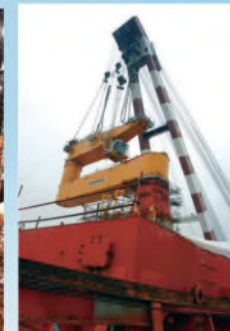
克令吊修理 Crane Repair
