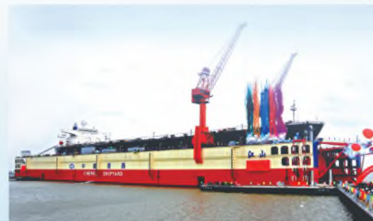
17万吨级“江山”坞（新荣） 170,000 DWT Floating Dock: "Jiang Shan"
