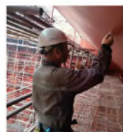
油漆干膜厚度控制 D.F.T Control
